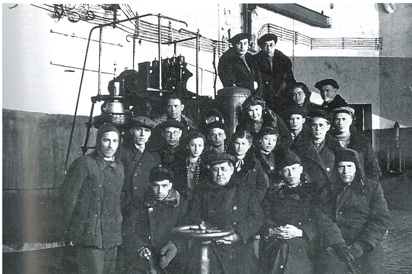
Группа студентов и преподавателей на работах по реконструкции электростанции института. В нижнем ряду справа на лево: И.Д. Кутявин, В.К. Щербаков, И.Н. Бутаков
