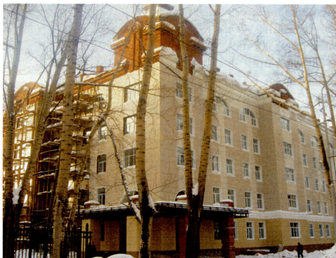
20-й корпус Института геологии и нефтегазового дела Томского политехнического университета.
