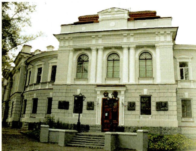
1-й корпус Института геологии и нефтегазового дела Томского политехнического университета.
