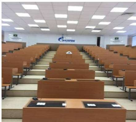
Рисунок 3.1.5 – Установка энергоэффективных светильников в ауд. №204 ГК.
