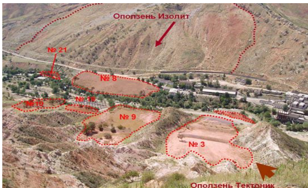
Рисунок 2.1.2 - Комплекс урановых хвостохранилищ Майлуу-Суу и оползне-опасные участки [41]
