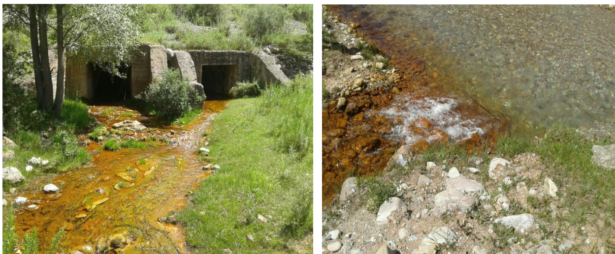
Рисунок 3.2.1- Выход воды из труб под хвостохранилищем, поступление в реку Туюк-Суу
