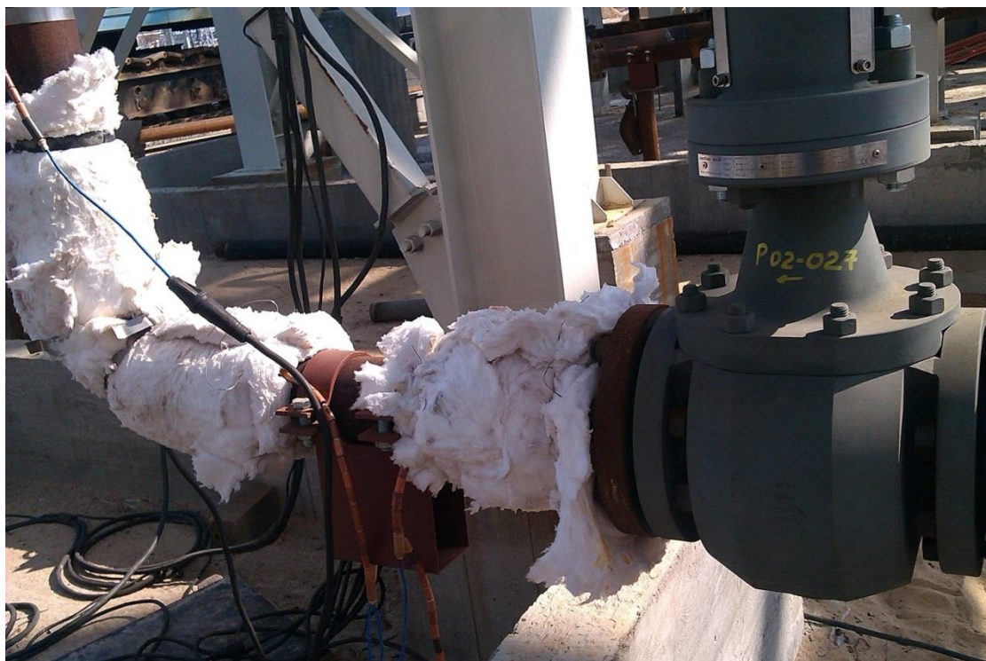
Рис. 8 - Термическая обработка сварных соединений
