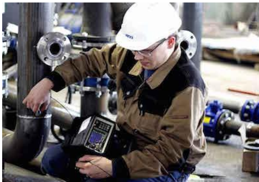
Рис. 10 - Проведение ультразвукового контроля трубопровода
