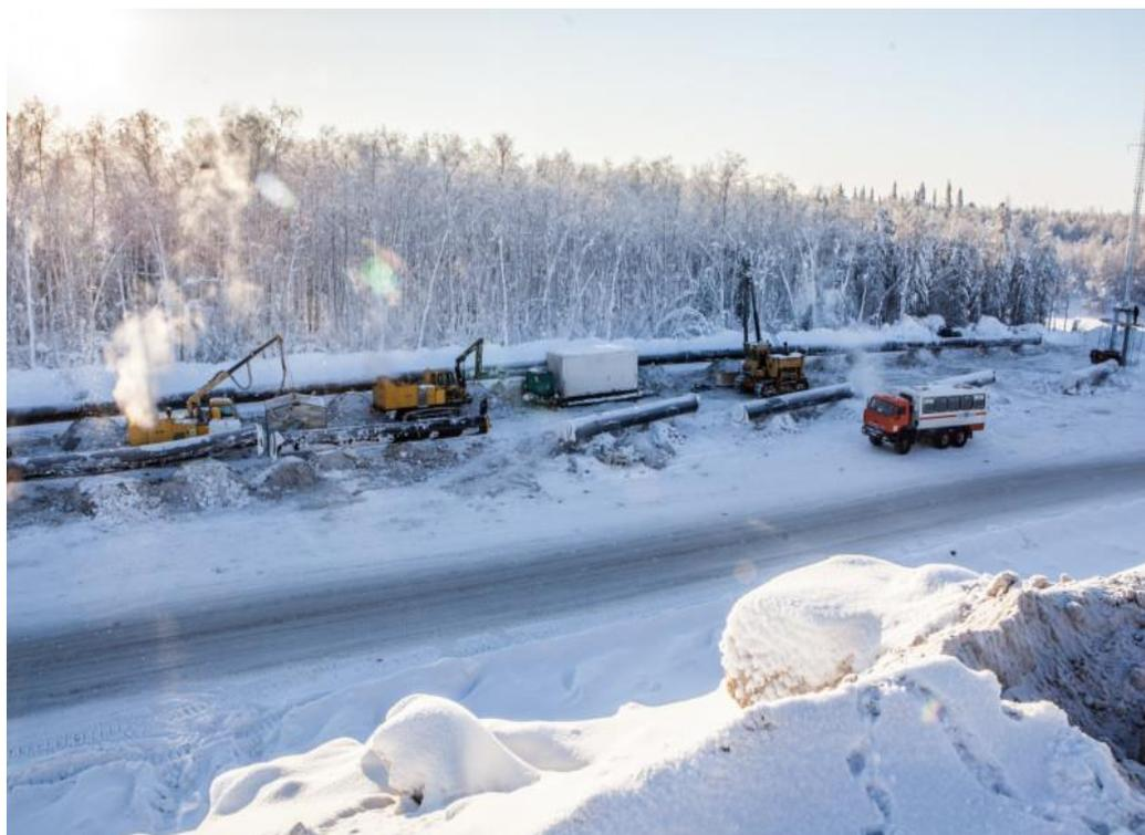
Рисунок 1.4.1 Укладка МН «Заполярье-Пурпе» в зимний период
