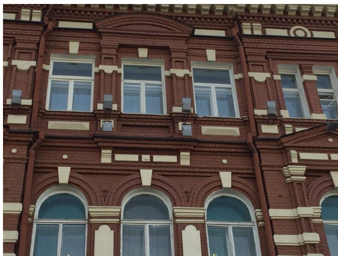
Рисунок 3.13 – Существующее оборудование наружного освещения
