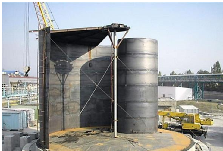
Рисунок 4 - Развёртывание рулонной стенки резервуара
