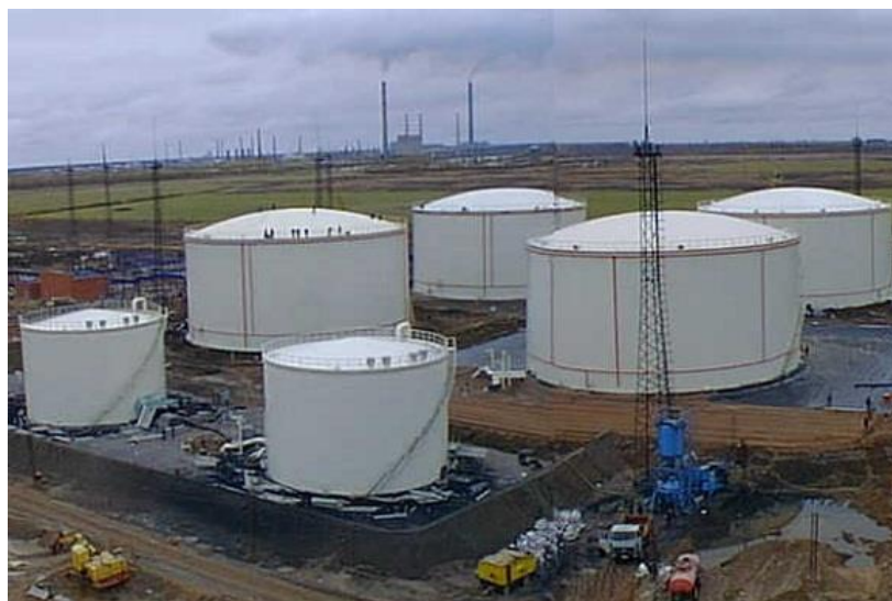
Рисунок 1 – Резервуар РВС – 20000 м³
