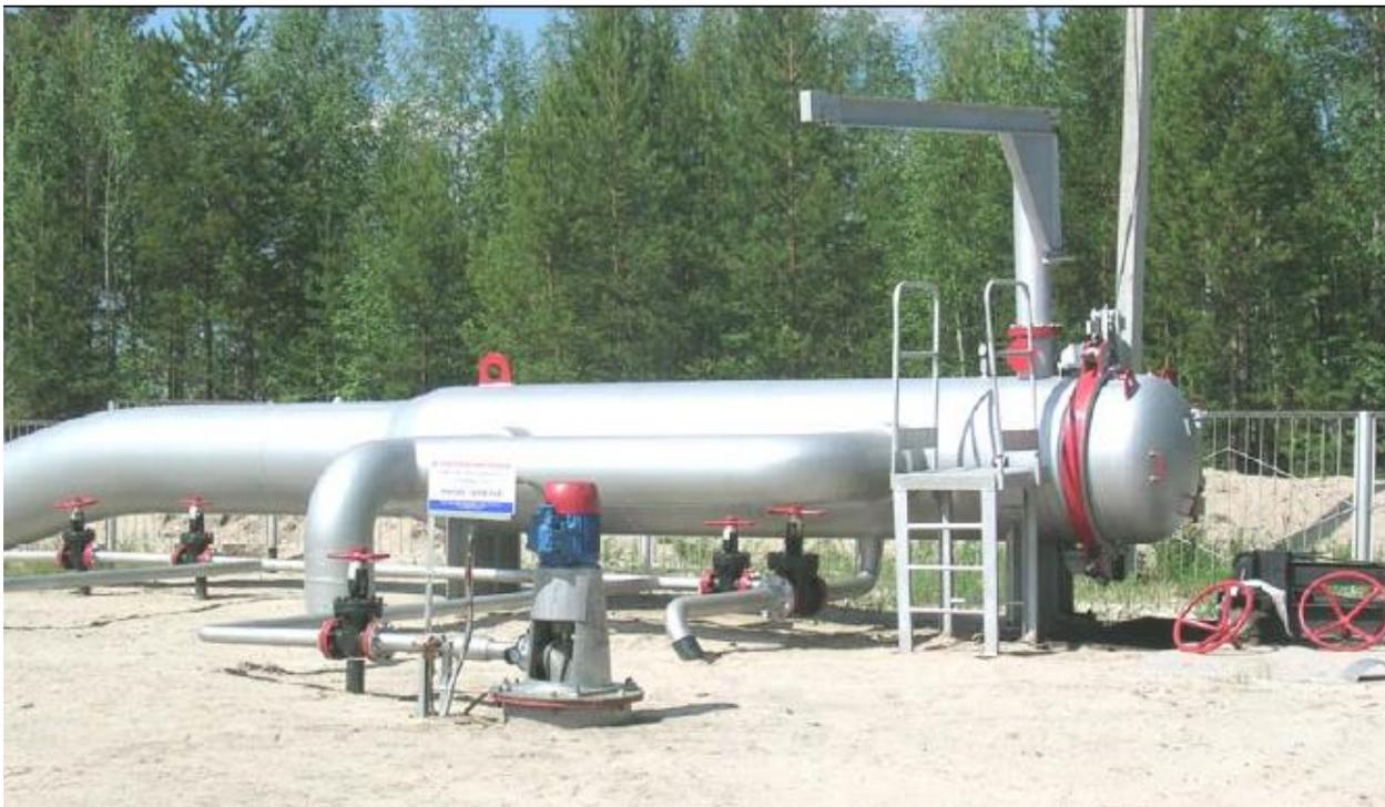
Рисунок 2.1.1 – Камера приема СОД
