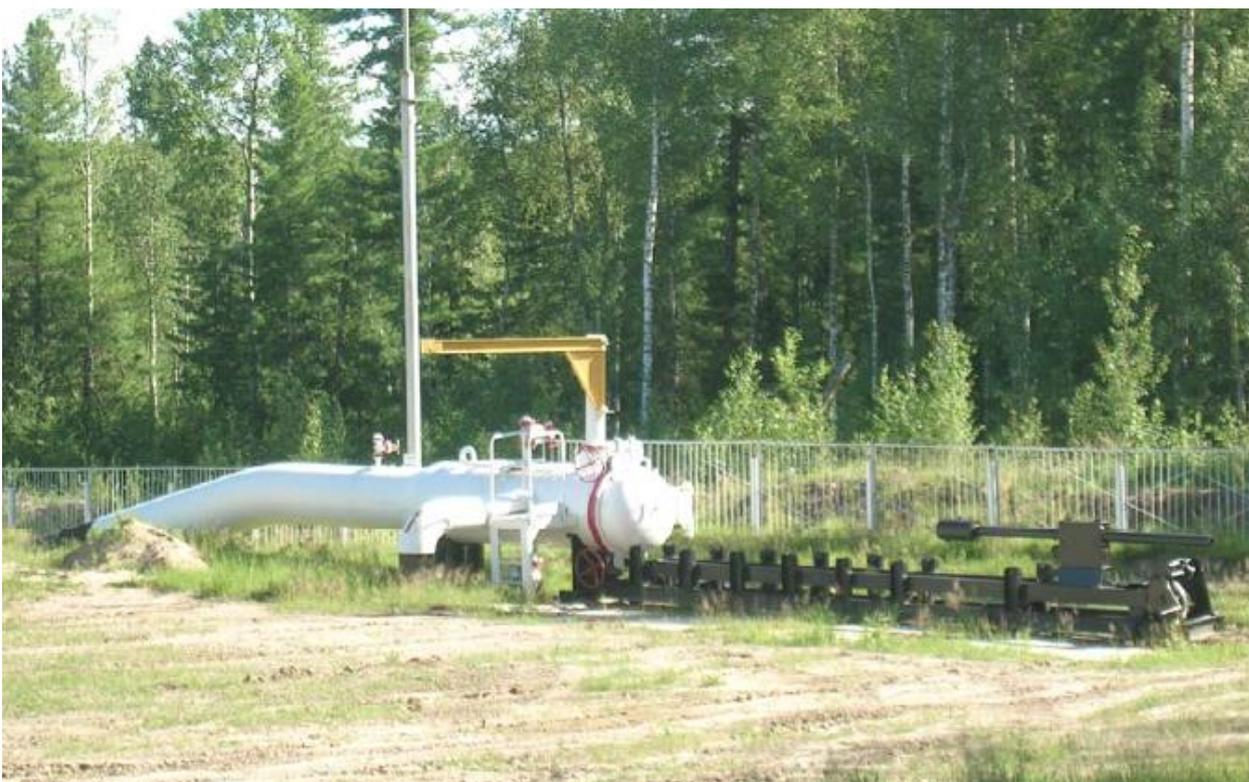
Рисунок 2.1.2 – Камера пуска СОД
