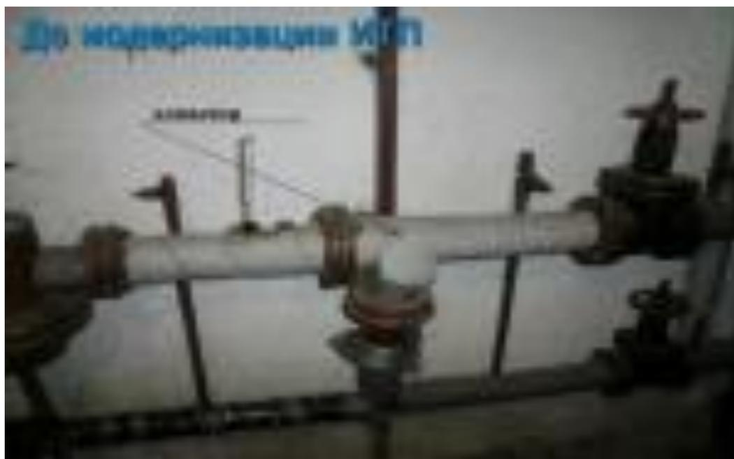
Рисунок 4 - До модернизации ИТП (с элеватором)
