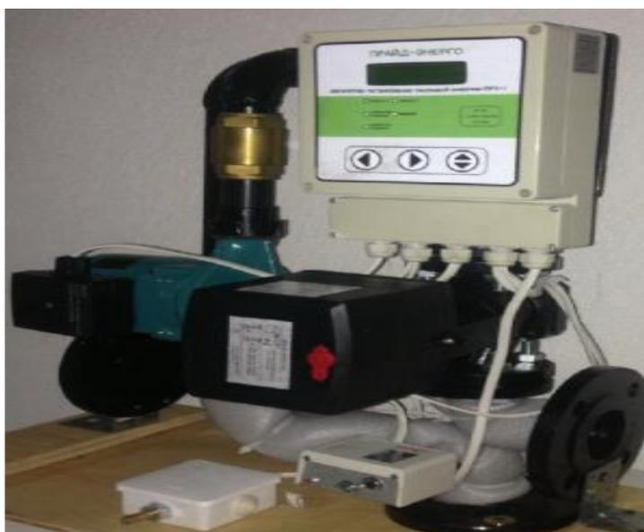
Рисунок 3 - Смесительные узлы автоматического погодного регулирования СУАПР.
