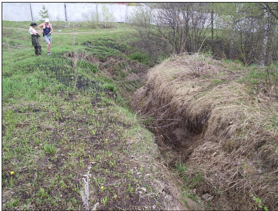
Рисунок 14 - Растущий овраг на берегу водохранилища [12]
