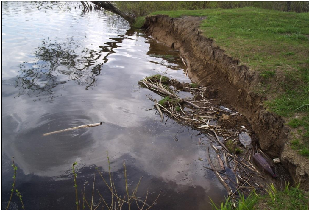
Рисунок 13 - Обрушение берега Кара-Чумышского водохранилища [12]
