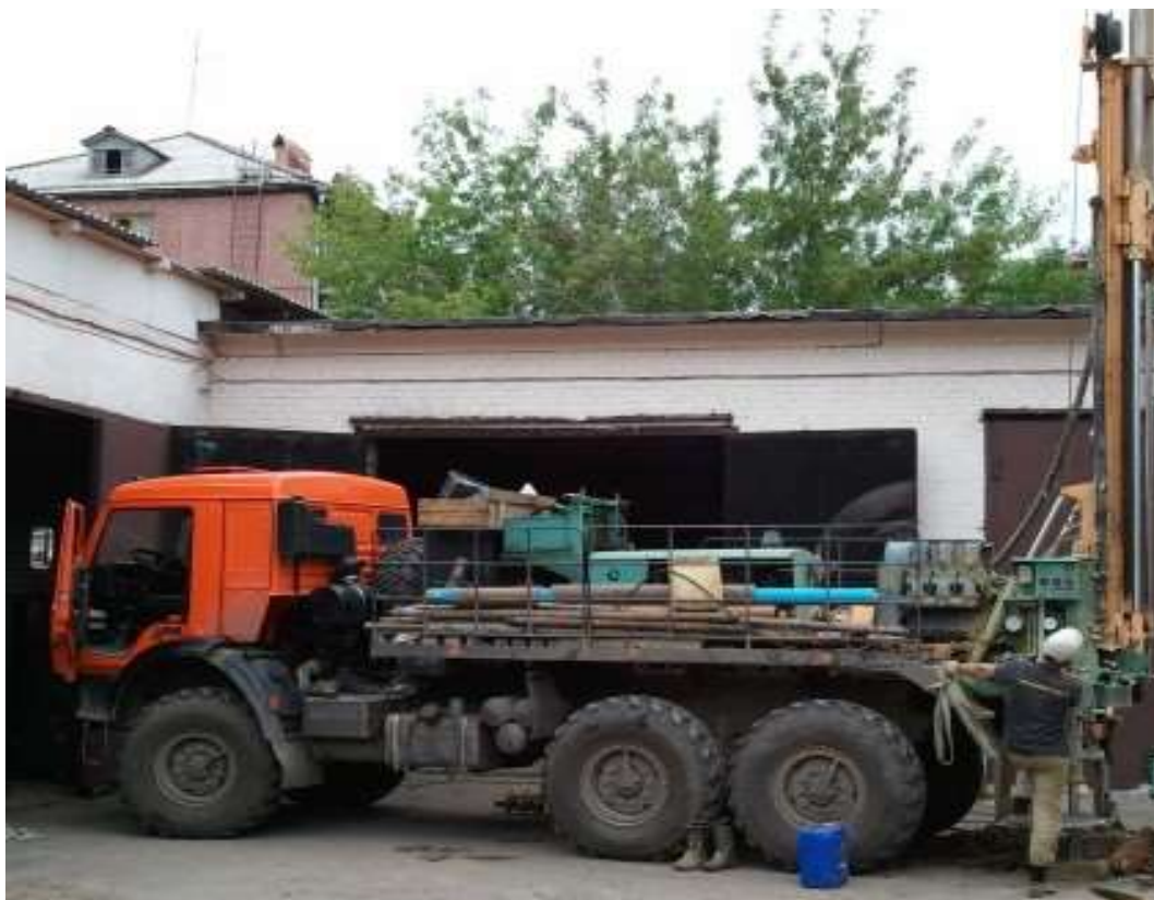
Рисунок 4.1 – Буровая установка ПБУ-2
