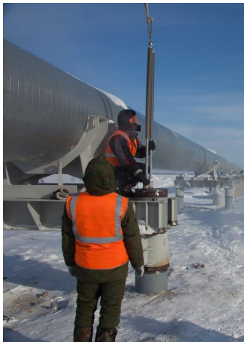
Рисунок 12 – установка термостабилизаторов в сваи опор нефтепровода
