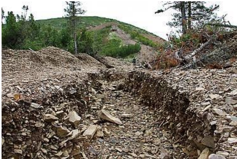
Рисунок 1.4 – Термоэрозионная промоина по автотракторной дороге в верховьях ручья Рудного
