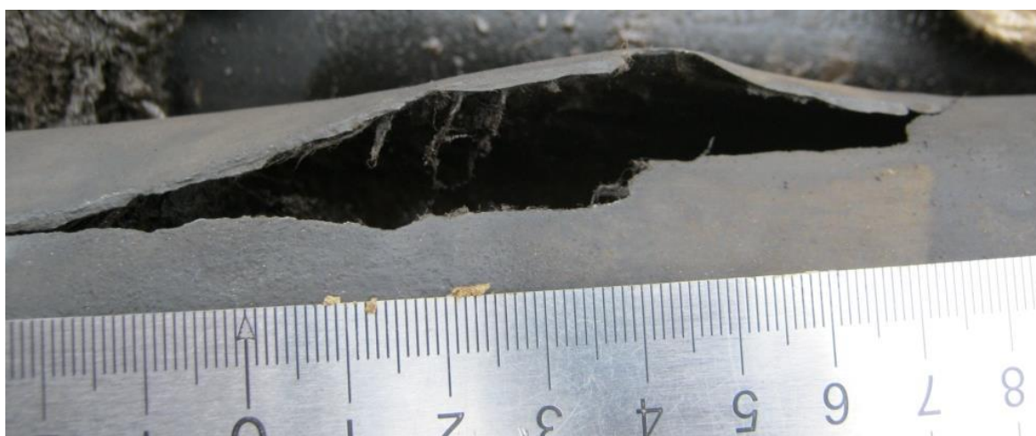
Рисунок 3.7 – Внешний вид повреждения на секции НКТ скважины 129
