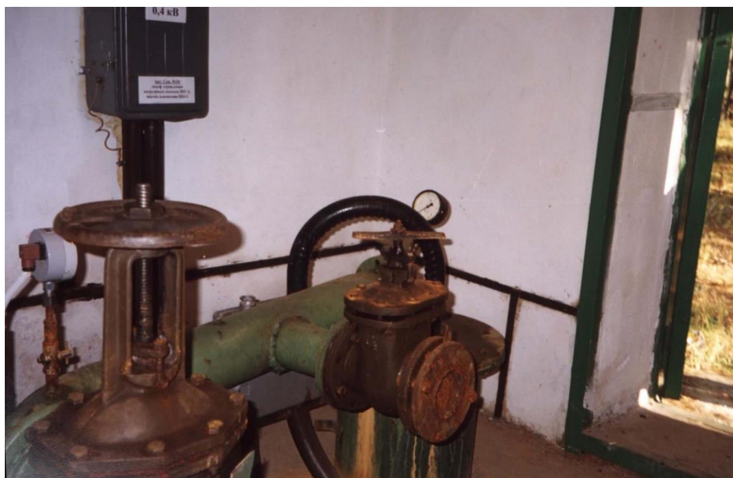
Рисунок 9. Оборудование оголовка водозаборной скважины
