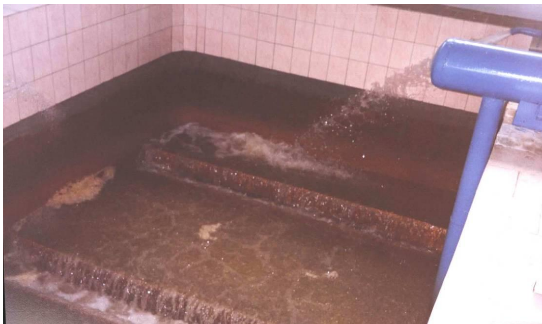
Рисунок 5. Скорый однопоточный фильтр с движением воды сверху вниз
