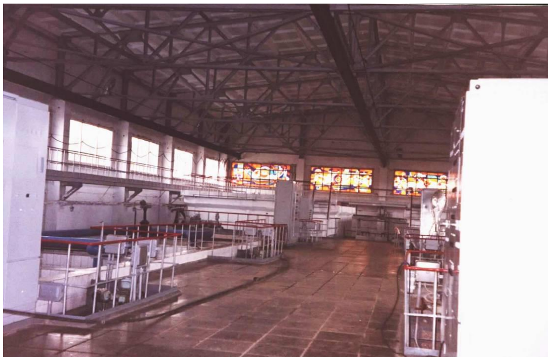
Рисунок 4. Общий вид фильтрового зала
