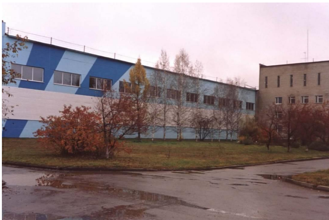
Рисунок 2. Общий вид станции обезжелезивания
