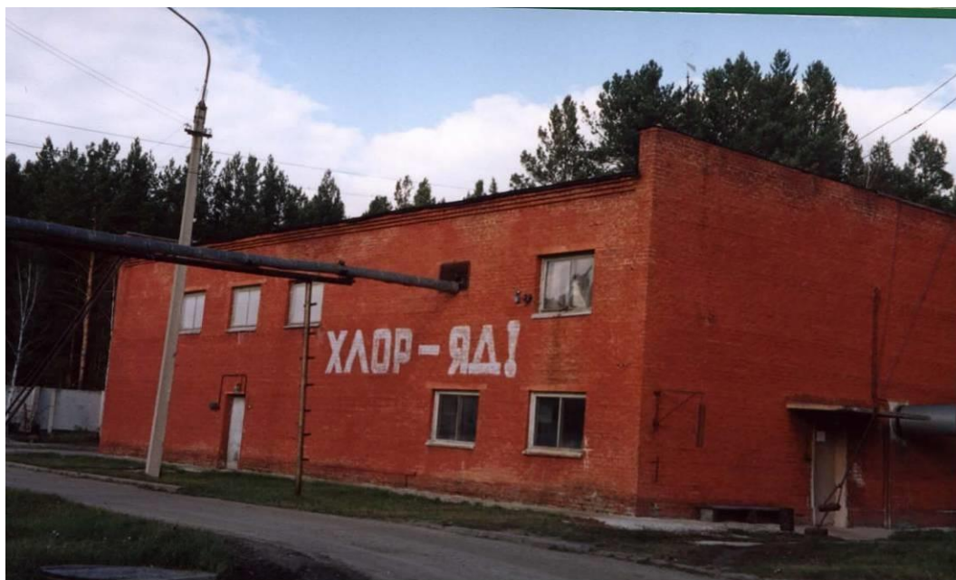
Рисунок 7 Хлораторная с расходным складом хлора
