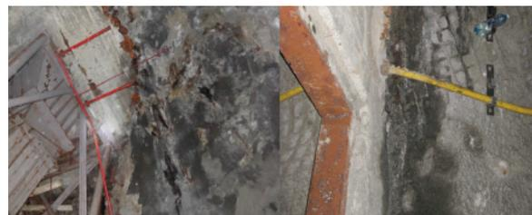
Рис. 1. Водопроявления в выработках кимберлитового рудника «Удачный»
