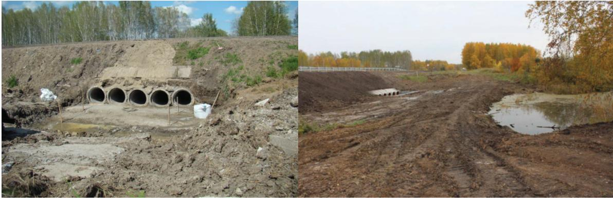
**Рис. 5.** Грунтовая плотина на р. Тюкалка и водопропускные трубы через автомагистраль по состоянию на 2014 г. (слева – июль 2014 г., справа – сентябрь 2014 г.)
