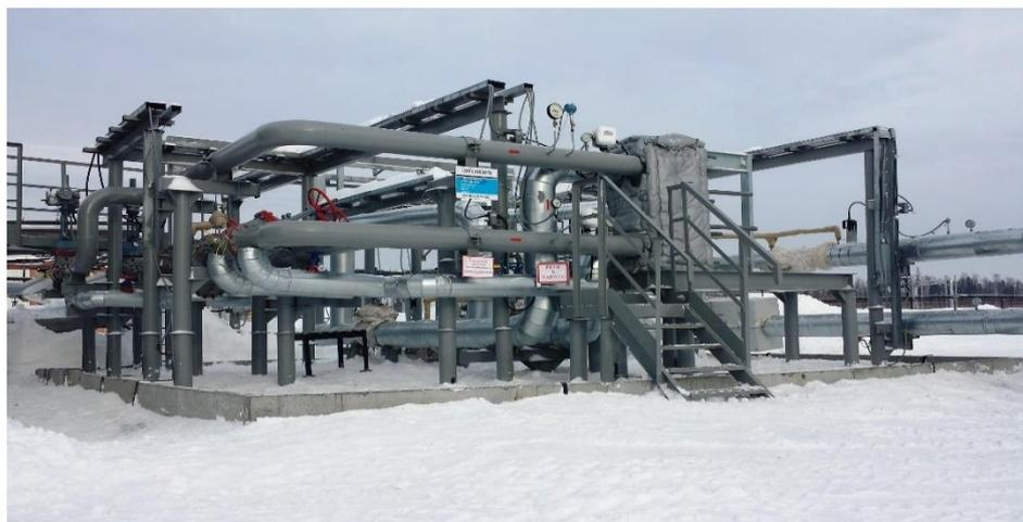
Рисунок 6 – Теплообменник пластинчатый РПТО
