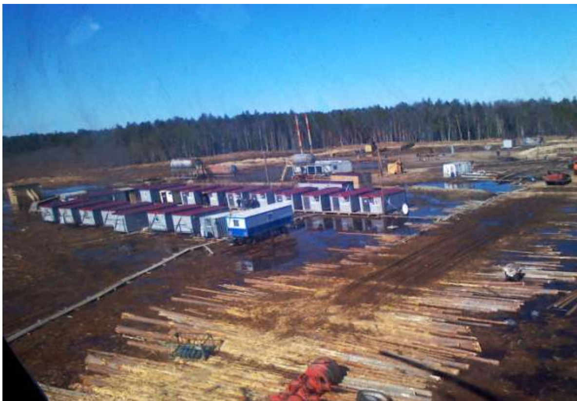
Рисунок 1.2 – Кустовая площадка скв. № 6. Жилая зона
