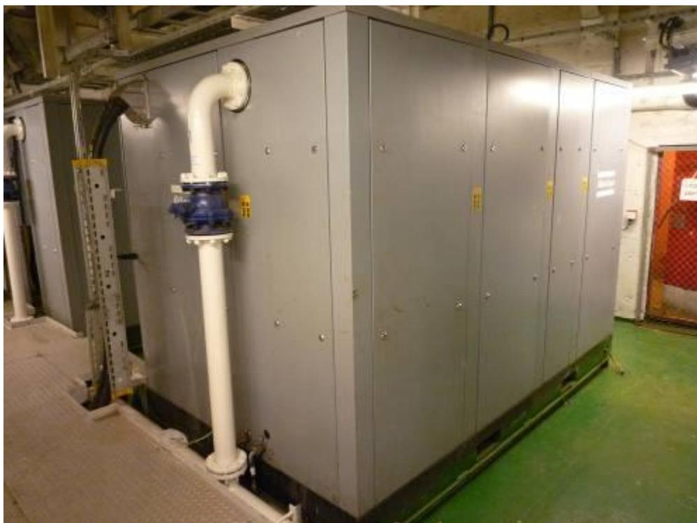
Рисунок 11 - Компрессор Atlas Copco GA-250-13
