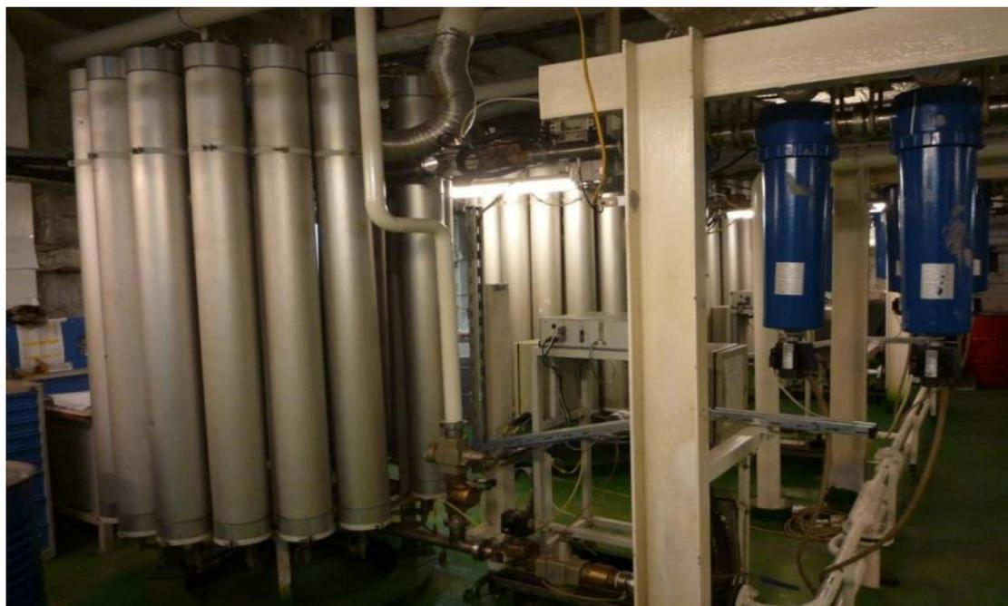
Рисунок 9 - Мембранный газоразделительный блок
