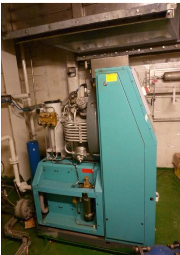
Рисунок 12 - Дожимной компрессор GIB 15.3-11-5
