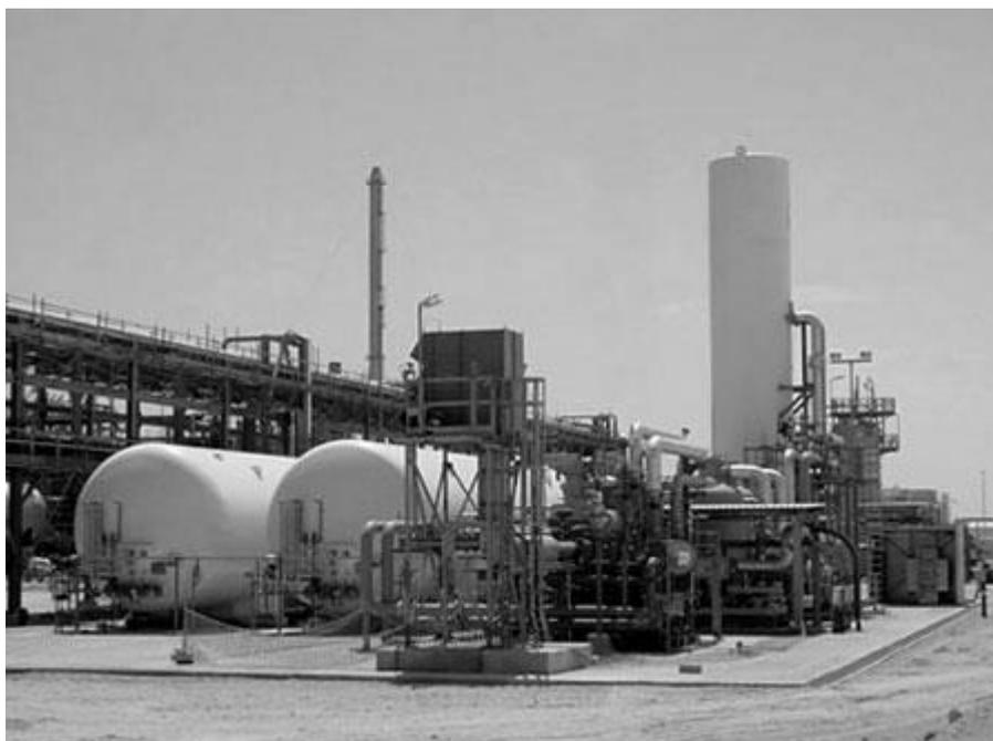
Рисунок 5 - Криогенная станция получения азота
