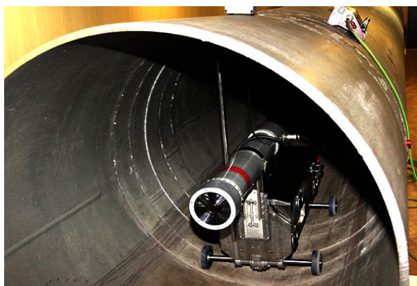
Рисунок 3 – Радиографическая установка для контроля сварных швов
