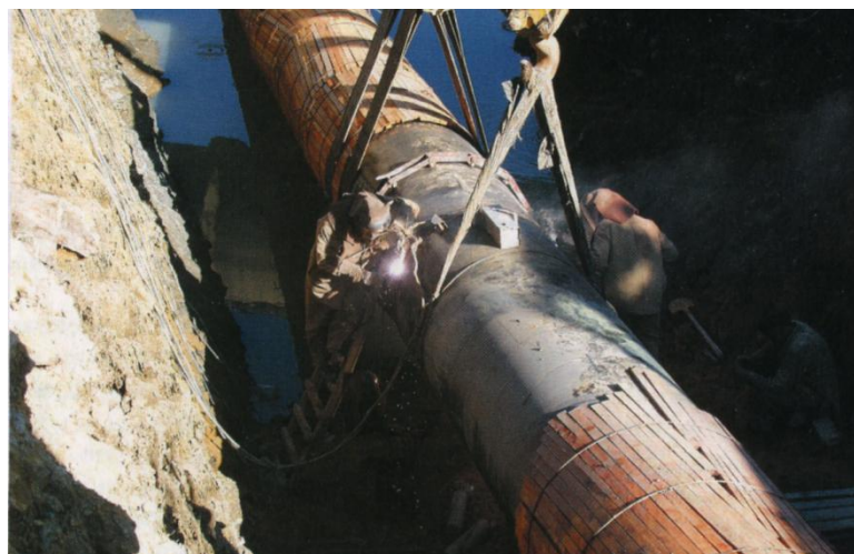
Рис. 4.1.3.1 – Футеровка трубопровода деревянными рейками
