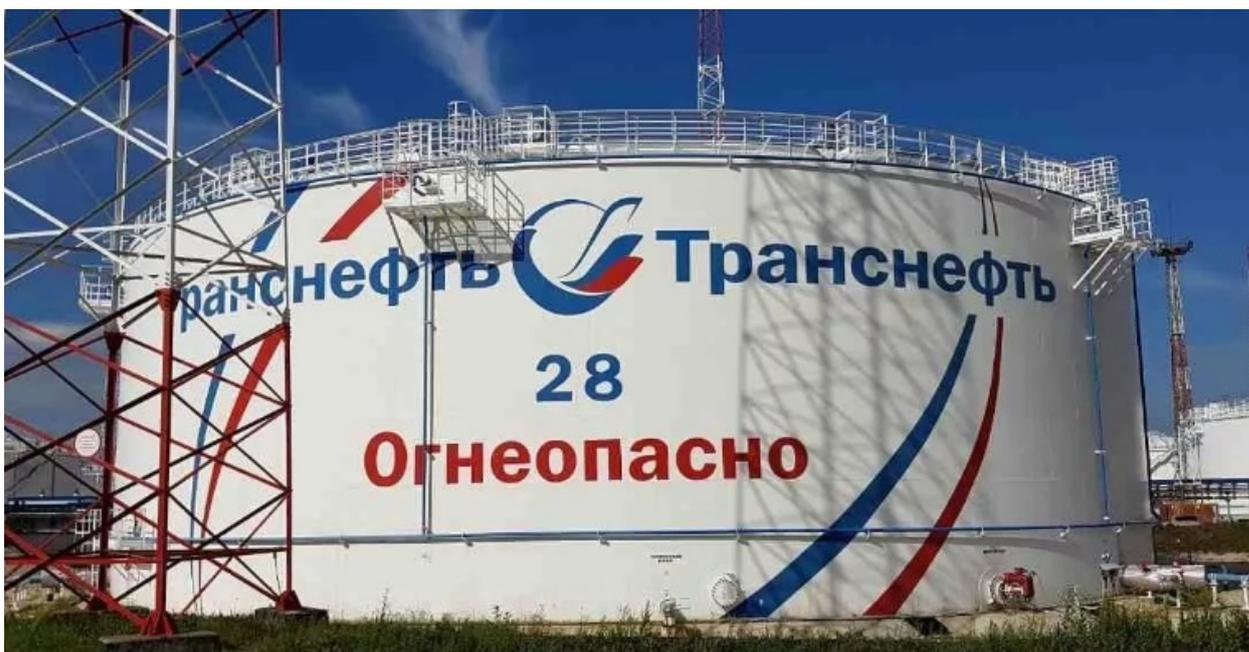
Рисунок 1 - Резервуары вертикальные стальные для хранения товарной и неподготовленной нефти
