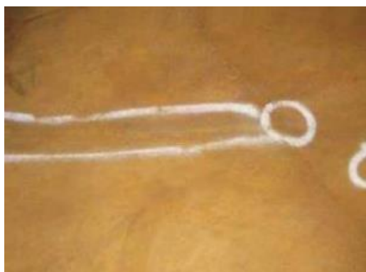
Рисунок 5 - Дефекты сварных соединений и вблизи уторного шва
