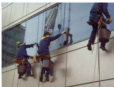
Рис. 3. Мойка окон производственного здания с использованием анкерных линий
