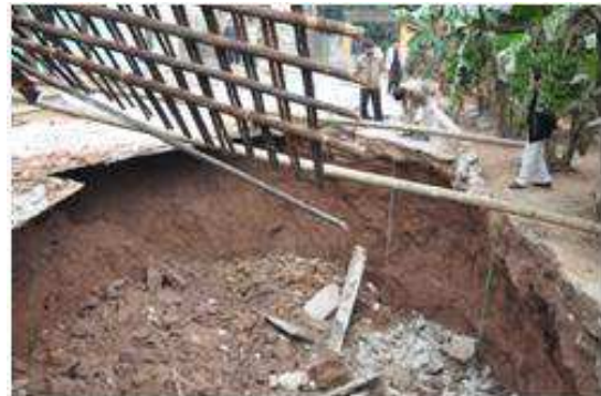
Рис.2 Суффозионная воронка площадью 30 м 2 [1]
