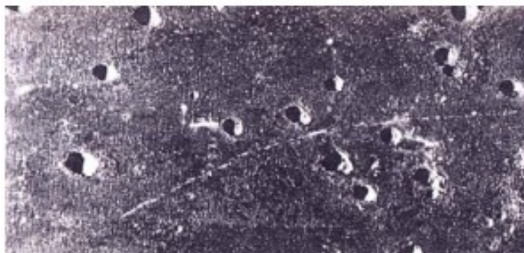
Рис. № 10 Питтинговая коррозия металла
