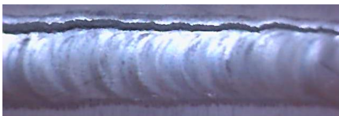
Рисунок – 1.12 - Внешний вид трещины в пробе 2
