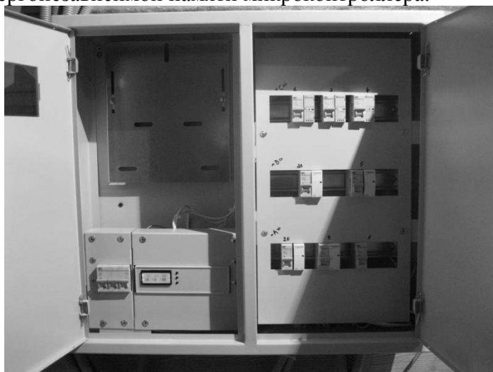
Рис. 3. Реле отключения неприоритетной нагрузки в собранном щите автоматики внизу слева (частный дом, пос. Росинка)
