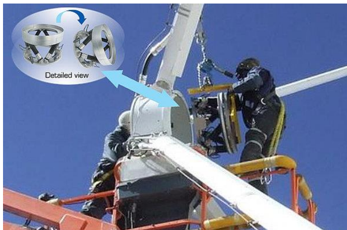
Рис. 1.1.28 - Инженеры устанавливают систему выравнивания PI hexapod 6-DOF в дополнительный рефлектор телескопа ALMA.
