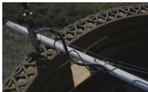
Рисунок 17 – Строительная печать с заполнением
