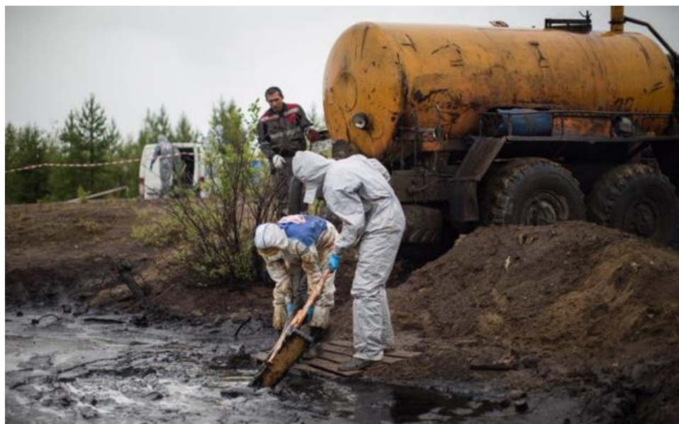
Рисунок 4.2 – Подготовительный этап работ
