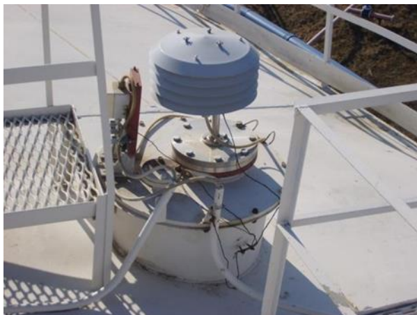
Рисунок 15 Радарный уровнемер системы KOR-VOL NT.
