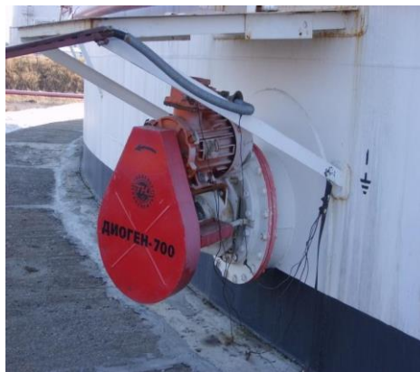
Рисунок 13 Устройство для размыва донных отложений «Диоген-700».
