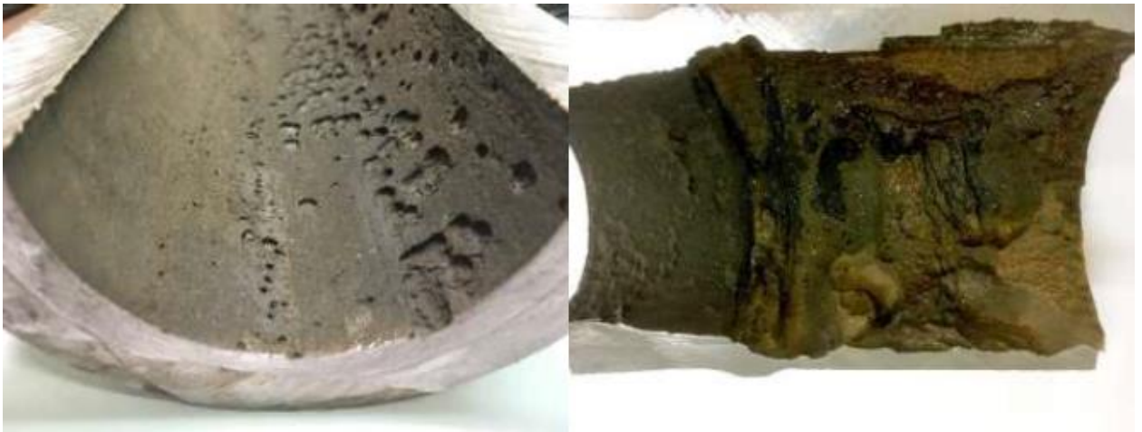
Рисунок 30 – Примеры протекания углекислотной коррозии внутренней поверхности насосно-компрессорных труб
