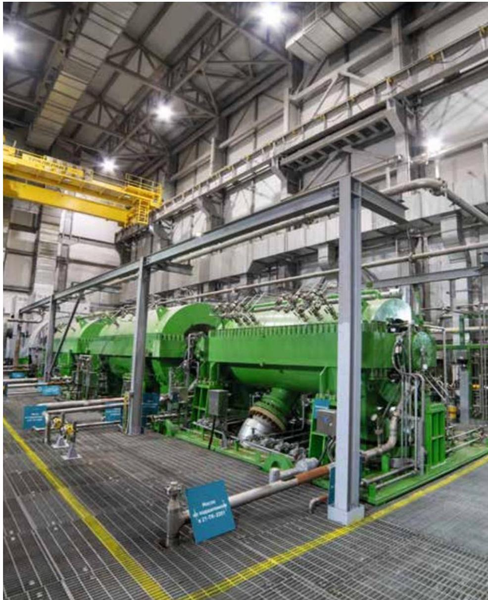
Рисунок 8 – Расположение центробежного компрессора в машинном зале
