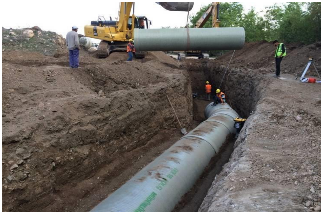
Рисунок 1 – Подземная укладка газопроводов
