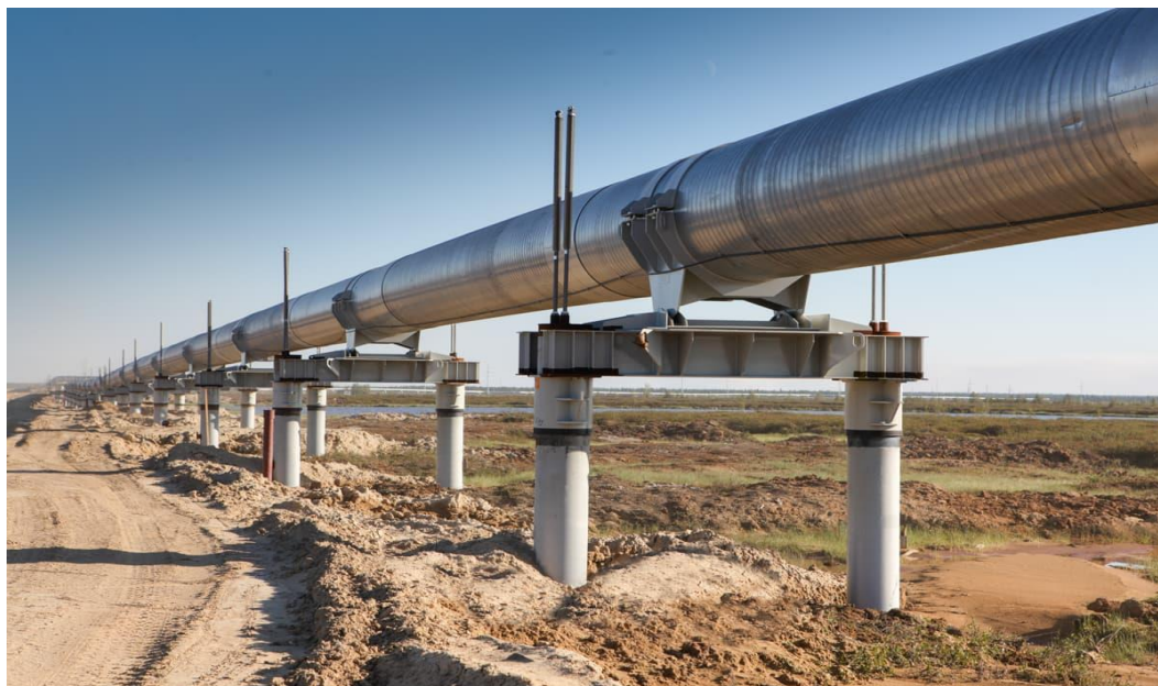
Рисунок 3 – Надземный способ сооружения газопровода
