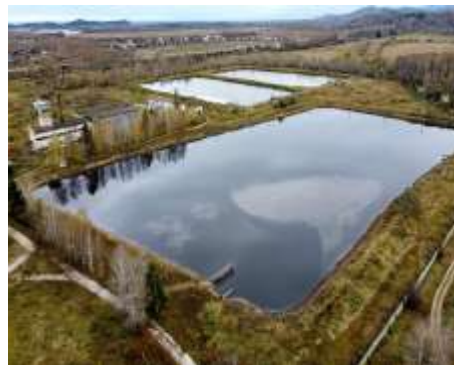
Рис. 2. Очистные сооружения Селенгинского ЦКК
