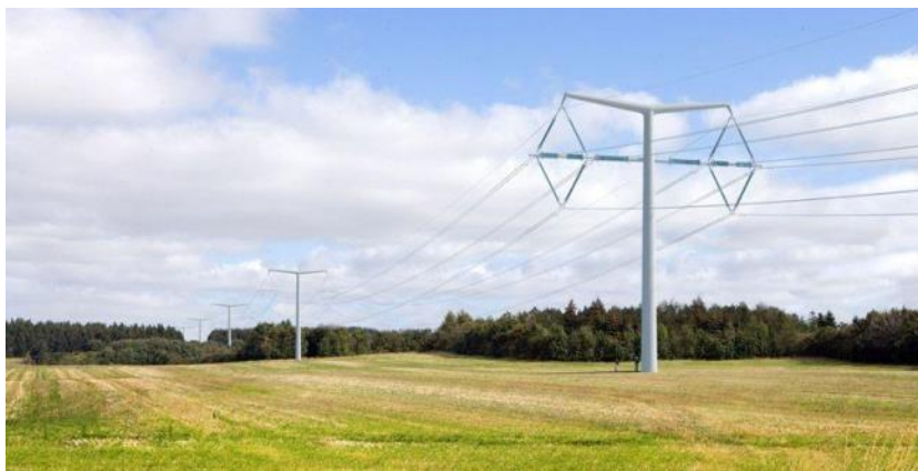
Рис. 1. Вариант опоры ЛЭП Bystrup
